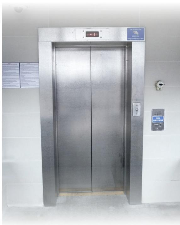
Выпускаются лифты для перевозки пожарных подразделений. Они имеют противопожарные двери шахты, а также в потолке люк размером 700x500 мм.
